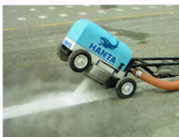
超高压水噴射状況
